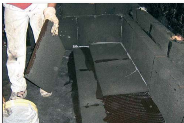
Verlegung der Bodendämmung
