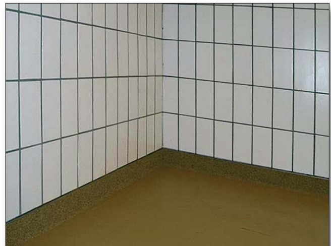
Wand mit Fliesenbelag und Boden mit Kunststoffbeschichtung
