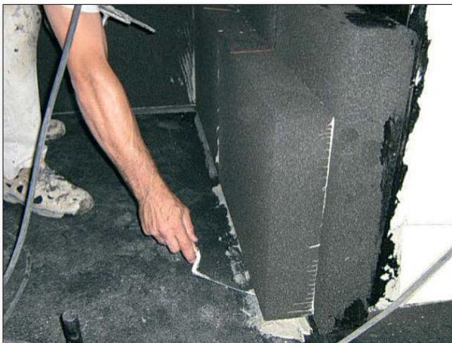
Wanddämmung in zwei Lagen
