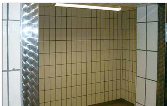
Kühlraum: Wände mit Fliesenbelag, Boden kunststoffbeschichtet
