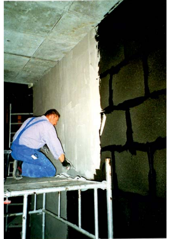
FOAMGLAS® Schachtdämmung mit Beschichtung
